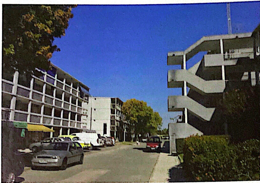
Figura 1. Racionalización: Los entresijos de losetas de ladrillo, los muros de bloque y los corredores facilitan la circulación en obra. Zona 1, 710 viviendas, Instituto CEDAS
