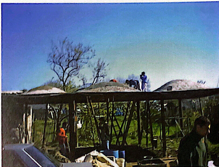
Figura 11. Cubiertas de vivienda con cúpulas de microhormigón. Fuente: Cátedra de Construcción, Ude- laR con el Movimiento Tacurú.
