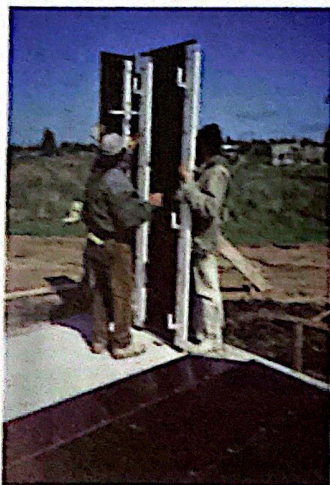
Figura 13. Muros de hormigón castrenoso con encofrados racionalizados. Sistema Consur 1.
