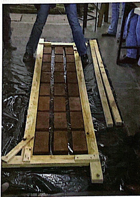
Figura 2. Prefabricación de losetas de ladrillo armado Fuente: Archivo Kruk, 2015.
