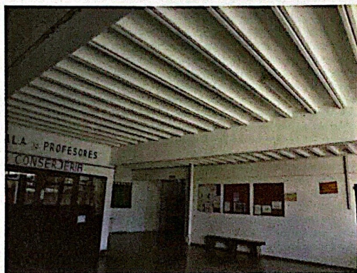
Figura 6. Entrepiso de prelosas nervadas de microhormigón.
