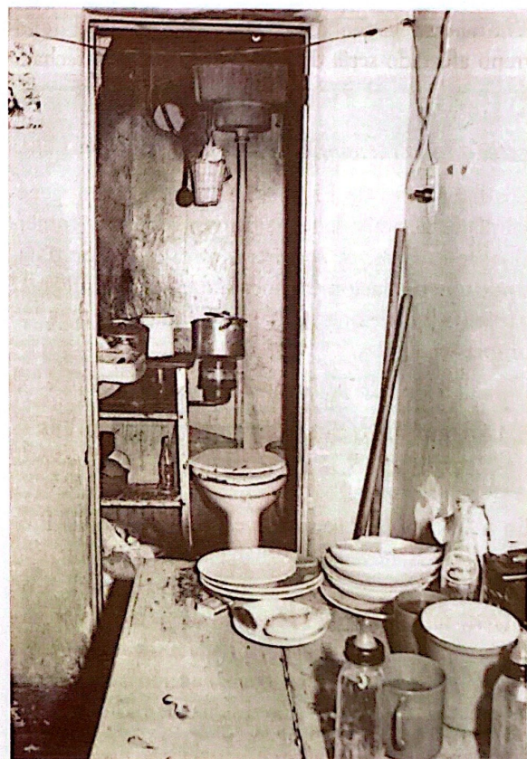
Figura 3: Situación de las condiciones físicas, 1972.
