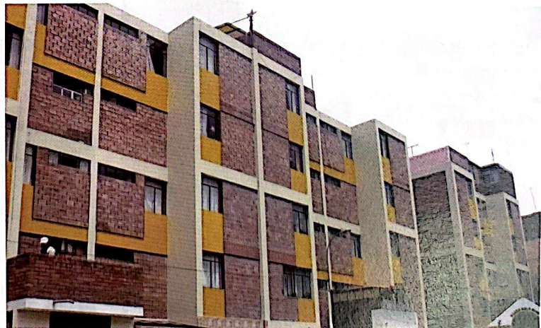
Figura 25. Muros cara vista y estandarización de vanos. Fuente: Fotografía de la autora, 2012.
