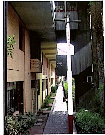
Figura 22. Circulaciones interiores al conjunto. Fuente: Fotografía de la autora, 2012.
