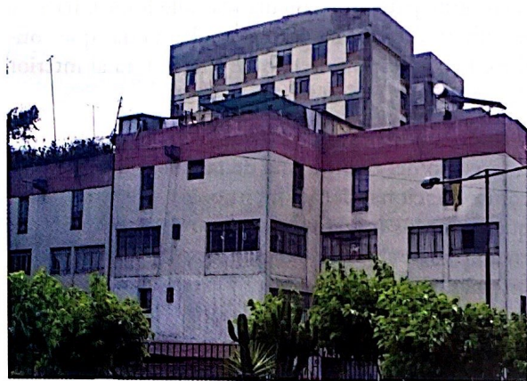
Figura 16. Fachada del conjunto por la calle Víctor Lira.
