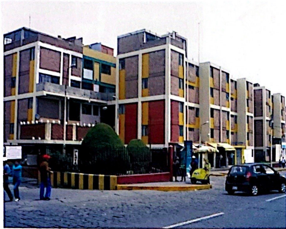
Figura 26. Vista de la etapa 2 por la calle San Juan de Dios. Fuente: Fotografía de la autora, 2012.
