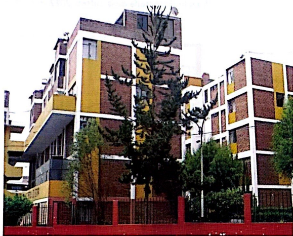
Figura 28. Vista de la etapa 3 por la calle San Juan de Dios. Fuente: Fotografía de la autora, 2012.
