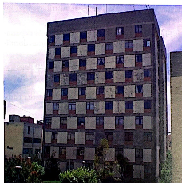
Figura 18. Vista del edificio de 11 pisos (bloque 5)
