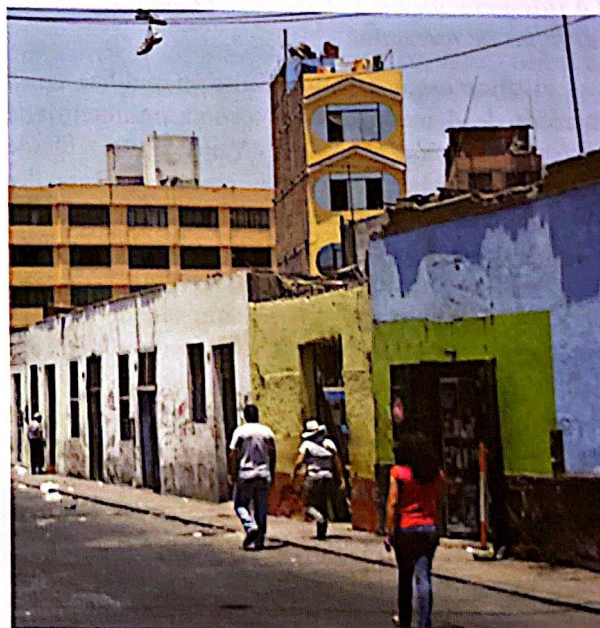
Figura 3: Fachada del solar.
