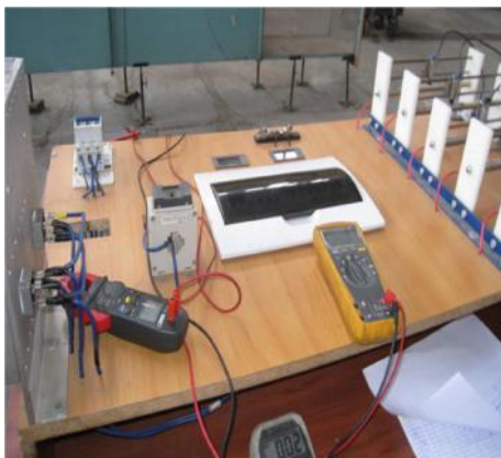
Fig.11 Tablero de control y mediciones.
