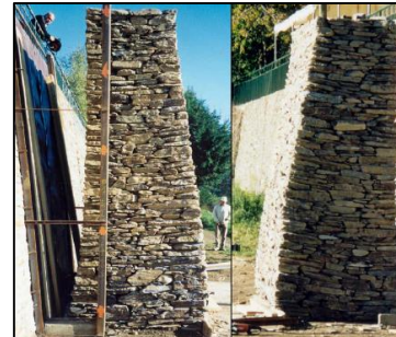
Figure 4. Dry Stone Wall hydrostatic test 1.1. Villemus et al, 2007).
