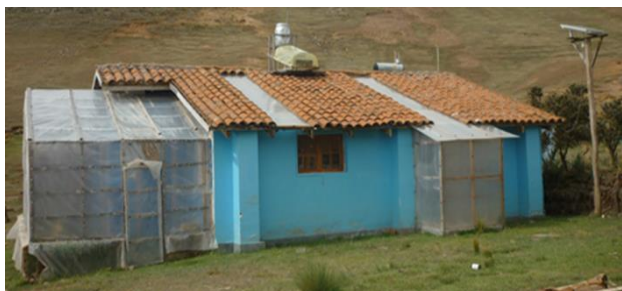
Fig.9 Vivienda rural bioclimática experimental construida en SFR.
