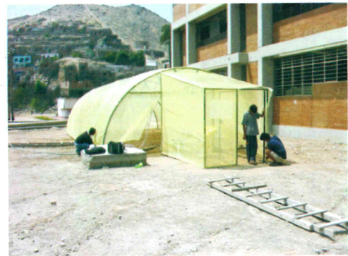
Fig. 1 Fotografía que muestra la instalación del polietileno.
