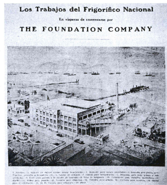
Fig. 2 Vista aérea del frigorífico nacional en la revista Ciudad y Campo .
