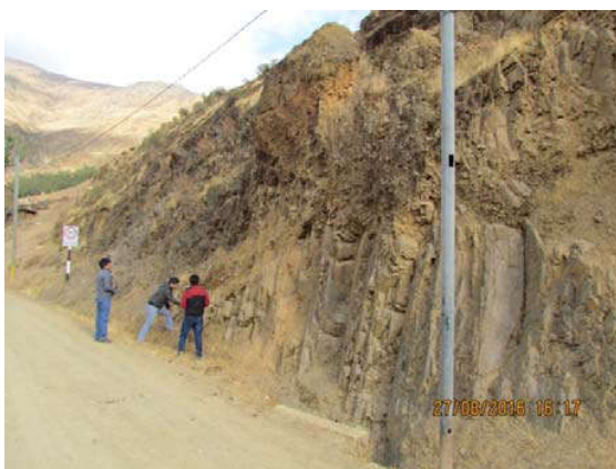
Figura 11. Suelo colgado en la pared izquierda del drenaje Piyaracra.
