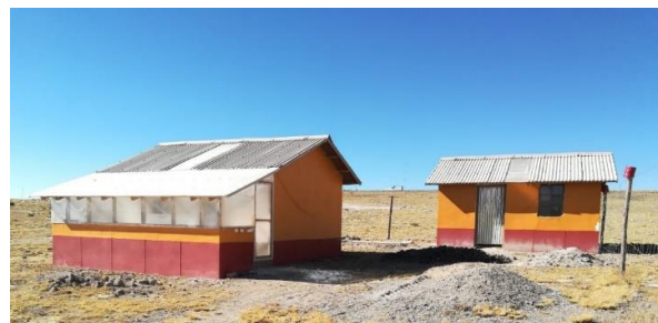
Fig. 1. Módulos construidos en el centro poblado de Imata, para efectos comparativos [2].
