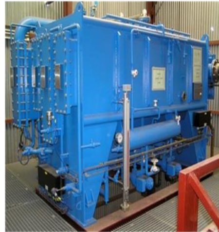
Fig. 25 Bomba de calor por absorción de doble efecto (PSA).
