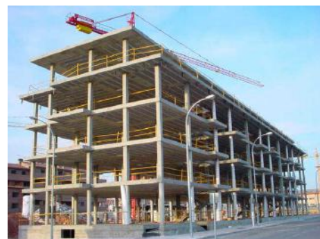
Figura 9. Losa de concreto armado
