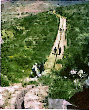
Foto 1. Tipón, complejos, caminos y canales de abastecimiento de agua acueducto del canal principal.
