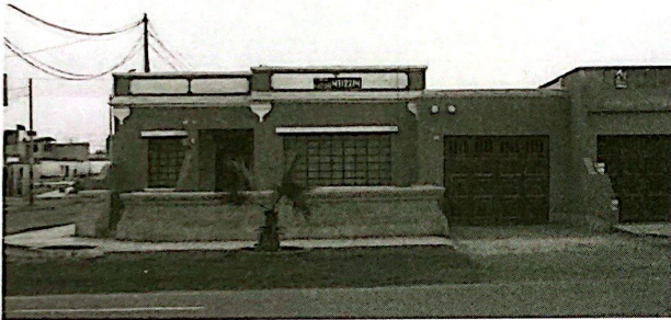
22. Lote 4 Mza. C Cornisas molduradas soportadas por ménsulas planas y molde del parapeto lo asocian a esta versión tradicional. Extensos voladizos laterales parecen contradecir la idea anterior
