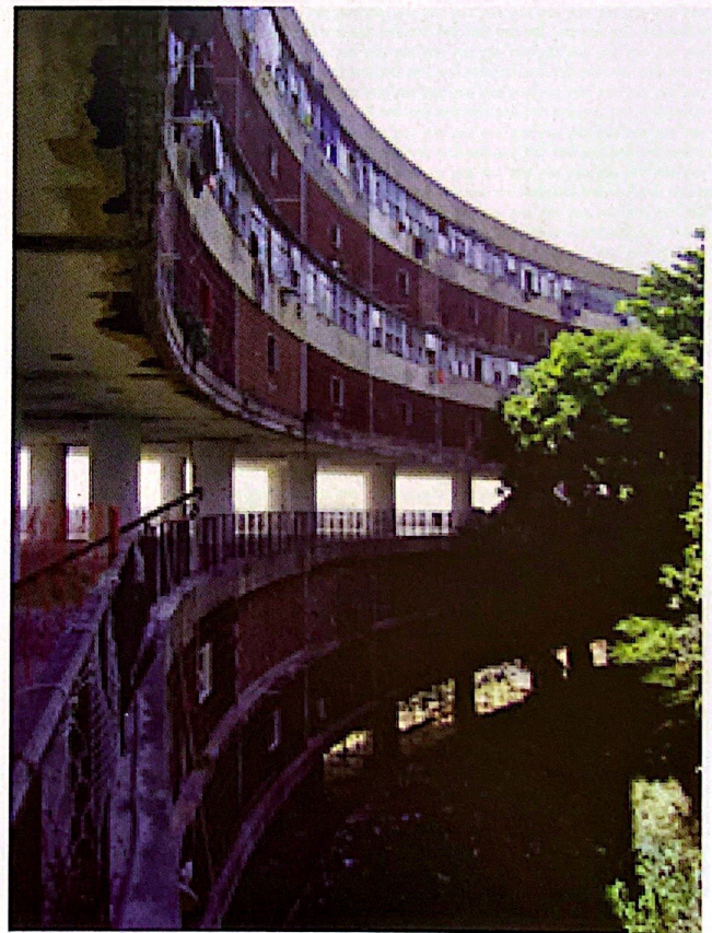
5. "Conjunto Residencial Pedregulho, Bloque A" - Arq. Afonso Eduardo Reidy - 1947-52. Fuente: Archivos propios.
