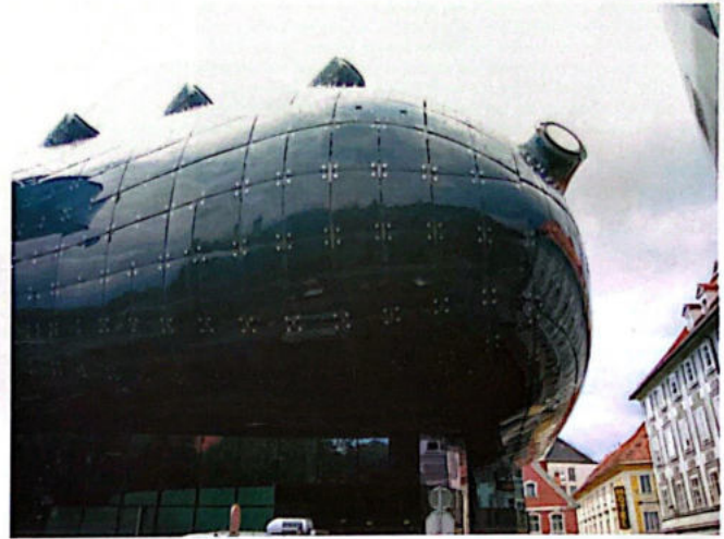
Fig. 7. Kunsthaus en Graz, Peter Cook, 2003. Discretización mediante paneles curvos. Fuente: http://goo.gl/JubBR
