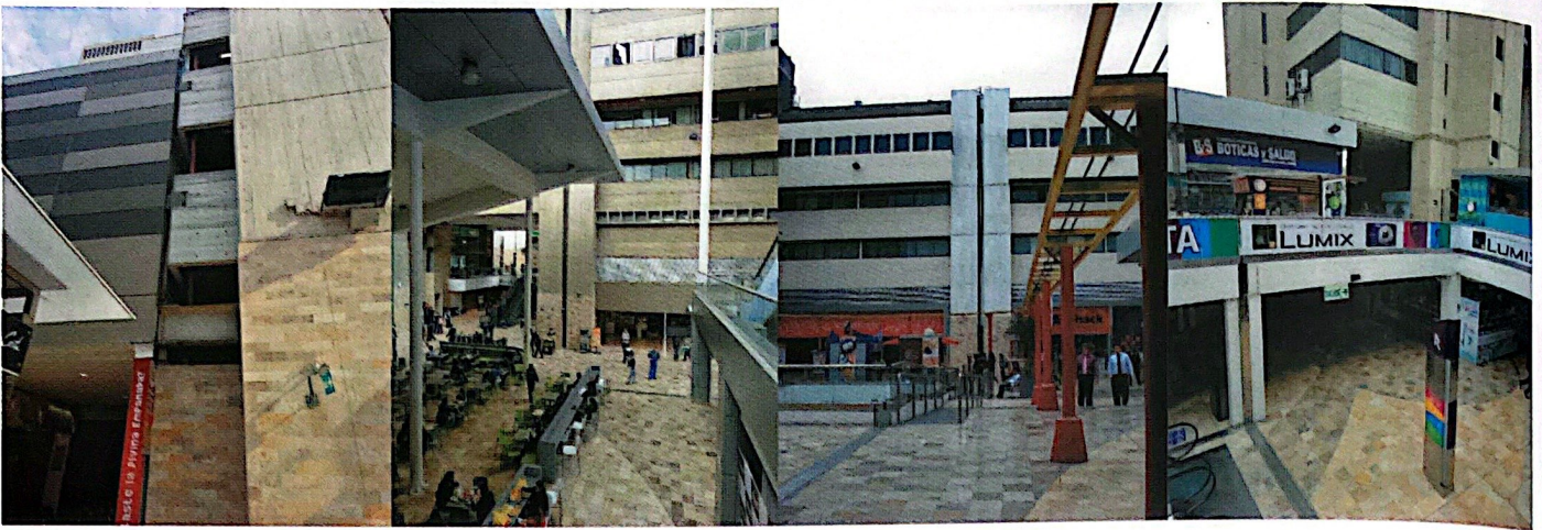
Fig. 9. Vistas interiores de la intervención arquitectónica remodelación y obra nueva Real Plaza - Centro cívico.
