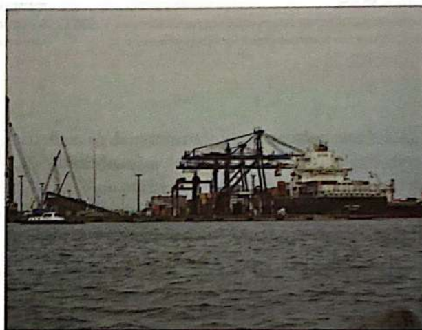
Figuras 2 y 3. Grúas puentes en Puerto del Callao Fuente: Archivo fotográfico Isis Bustamante, 2015.
