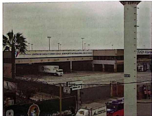
Figura 11. Centro logístico, Centro de carga de Aeropuerto Av. Faucett Fuente: Archivo fotográfico Isis Bustamante, 2015.
