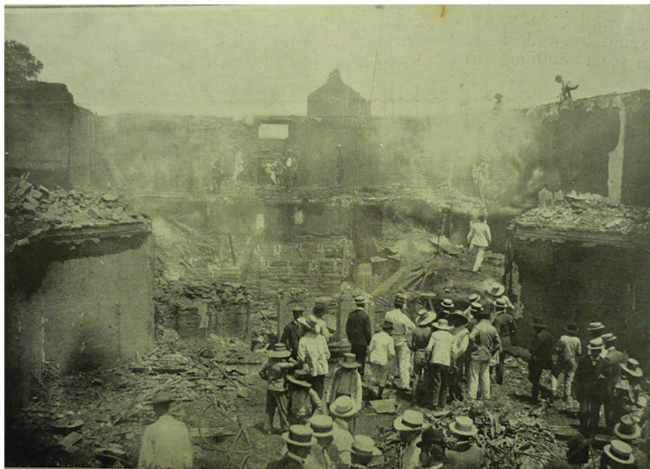
Figura 2. El teatro municipal completamente destruido. Vista interior tomada el 22 de febrero a las 6 de la mañana. Nota. Tomado de la Revista Mundial (1910).
