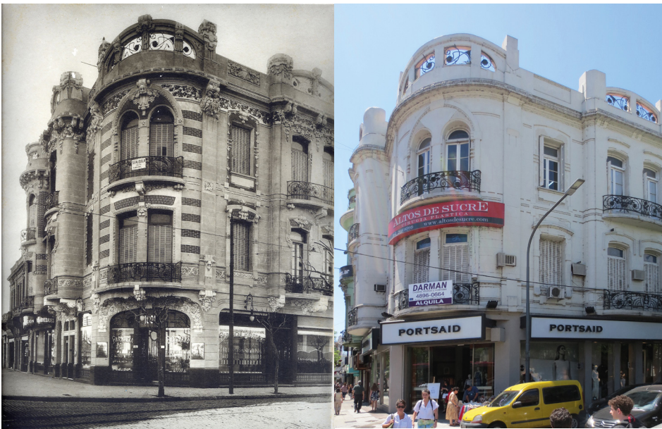
Figura 19. Edificio de Domingo Brignoni, Arq. B. Pedrotti, en avenida Cabildo, Buenos Aires, Argentina. A la izquierda en una fotografía de inicio siglo XX. A la derecha foto actual. Archivo General de la Nación Argentina y archivo fotográfico de la autora, 2018.
