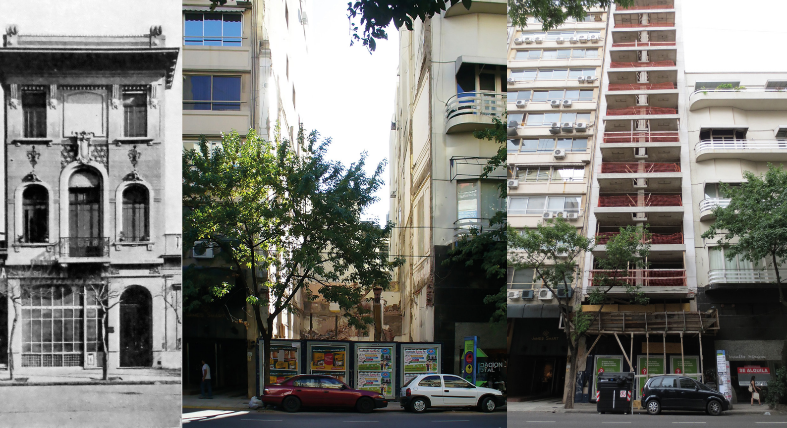
Figura 11. Buenos Aires, Argentina, Petit Hotel, Arq. L. Broggi. Ejemplo de demolición y nueva construcción..
