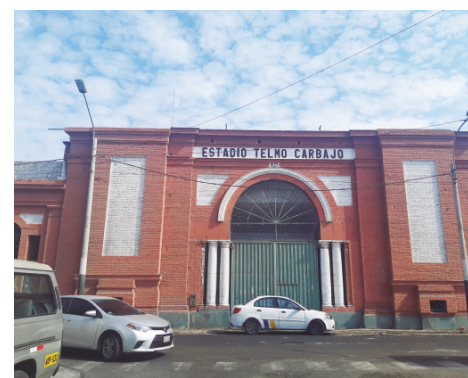
Figura 08. Fachada del Estadio Telmo Carbajo. Archivo fotográfico de la autora, 2019.
