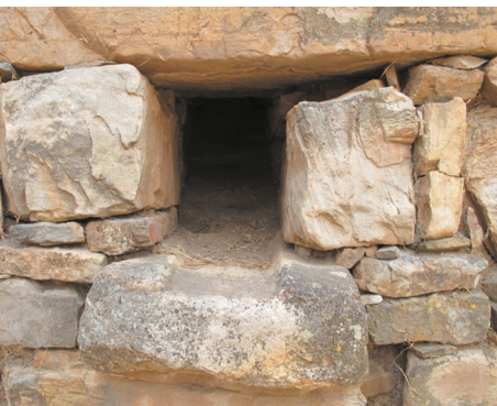
Figura 16. Vertedero lateral – canal El Caño. Archivo fotográfico de los autores, 2018.
