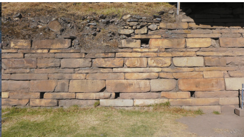
Figura 20. Enchape de piedra en la cara oeste del edificio A. Archivo fotográfico de los autores, 2018.
