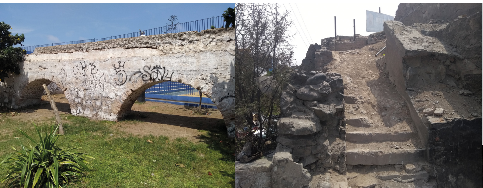
Figura 6. Acueducto de la Hacienda Villa Chorrillos calle Antarquí. Archivo fotográfico del autor, 2019..
