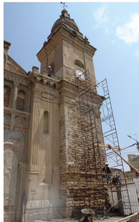
Figura 13. Torre lateral derecha de la Iglesia Matriz de Jauja, en proceso de intervención. Archivo fotográfico de Percy Vilchez, 2010.
