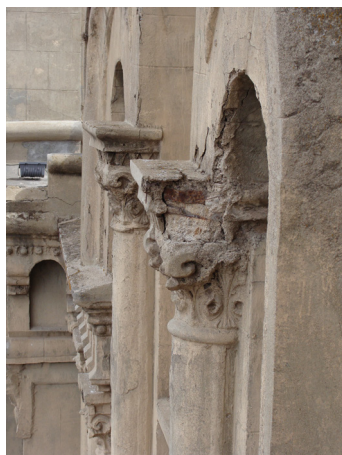
Figura 8. Detalle de capitel de la Iglesia Matriz de Jauja, en el proceso de diagnóstico para elaborar el expediente técnico Archivo fotográfico de Armando Chipána, 2009.
