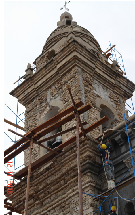
Figura 18. Torre campanario de la Iglesia Matriz de Jauja, en proceso de retiro del enlucido de cemento. Archivo fotográfico Dirección Desconcentrada Cultura-Junín, 2010.
