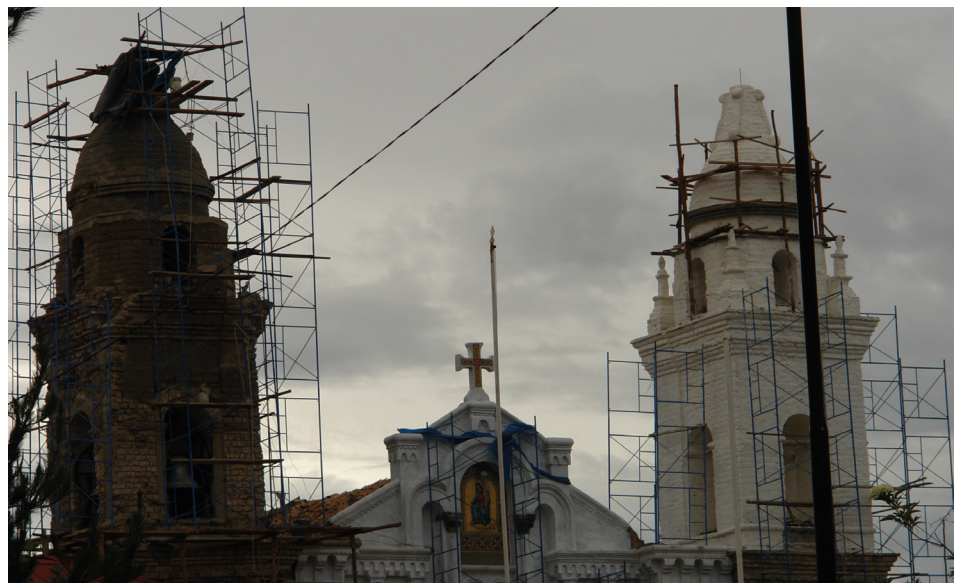
Figura 17. Iglesia Matriz de Jauja. Aplicación de enlucido de cal, durante el proceso de intervención. Archivo fotográfico Dirección Desconcentrada Cultura-Junín, 2010.
