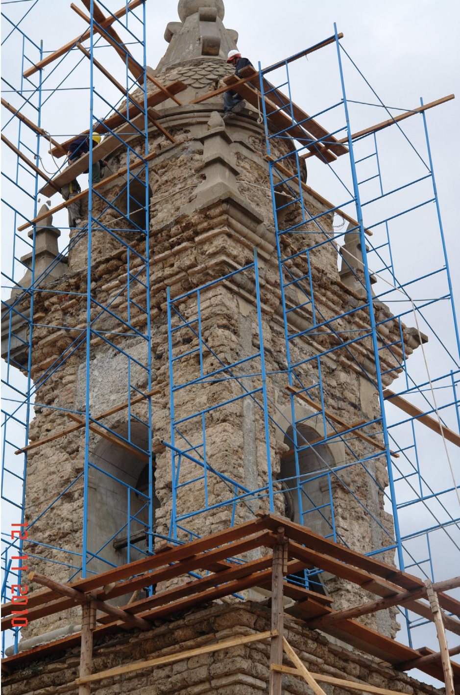
Figura 9. Torre de la Iglesia Matriz de Jauja, en proceso de intervención. Archivo Direccion Desconcentrada Cultura-Junín, 2010.
