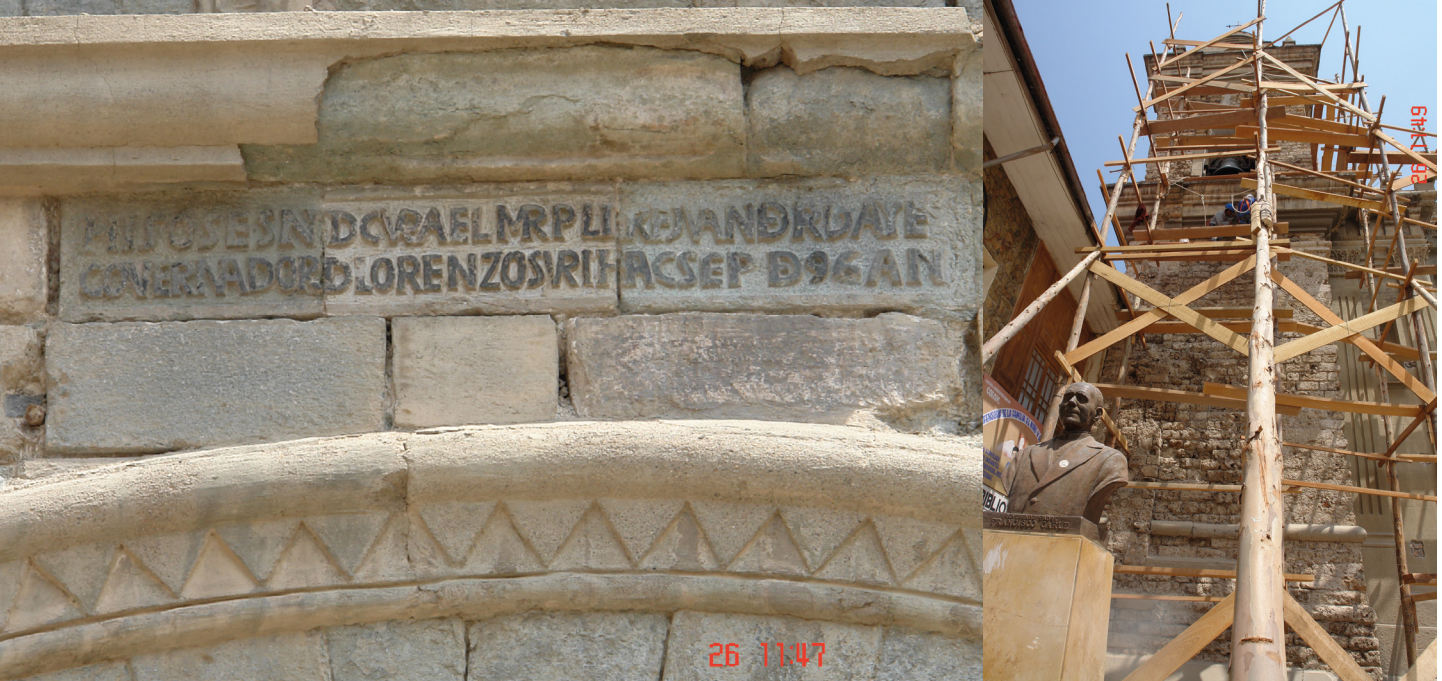
Figura 15. Inscripción del siglo XVIII en el friso de la parte superior central del pórtico, de la Iglesia Matriz de Jauja, evidenciado al liberarse el enlucido de cemento antiguo. Alude al Cura y Gobernador de la época. Archivo fotográfico Dirección Desconcentrada Cultura-Junín, 2010.
