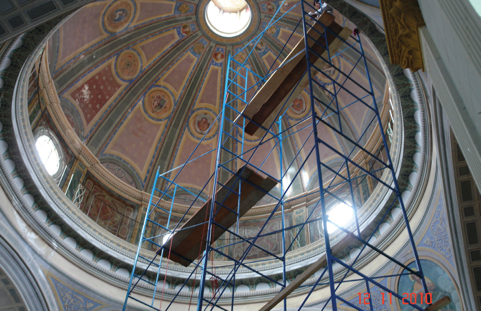
Figura 19. Cúpula de la Iglesia Matriz de Jauja, en proceso de intervención. Archivo fotográfico Dirección Desconcentrada Cultura-Junín, 2010.
