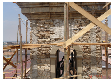
Figura 14. Detalle de la "torre campanario" de la Iglesia Matriz de Jauja, en proceso de intervención. Archivo fotográfico de Percy Vilchez, 2010.
