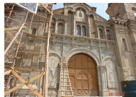
Figura 10. Iglesia Matriz de Jauja, evidenciando sobre el pórtico el encha-pe de piedra de principios del siglo XVIII. Archivo fotográfico de Percy Vílchez, 2010.
