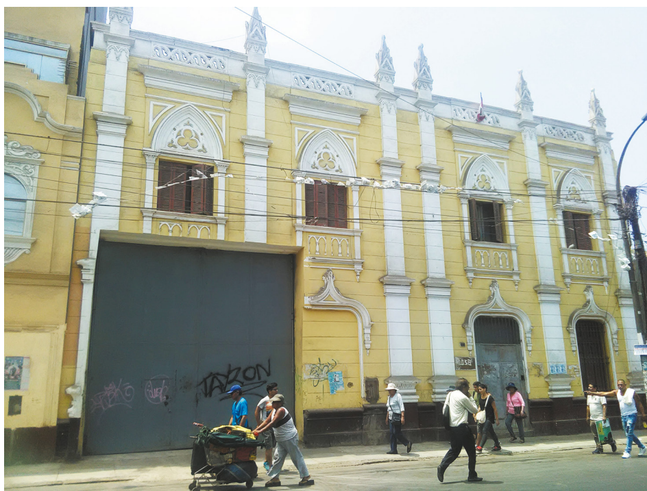
Figura 14. Ejemplo de actividades en las calles en un barrio deteriorado. Edificio de Valor Monumental en Jirón Junín. Archivo fotográfico personal, 2017.
