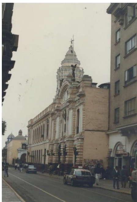
Figura 11. Vista del inmueble hacia el lado del jirón Conde de Superunda. Archivo del Programa Municipal de Recuperación del Centro Histórico de Lima (PROLIMA), 1996.
