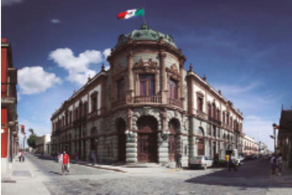
Figura 17. Teatro Macedonio Alcalá. Recuperado de http://www.epdlp.com/edificio.php?id=5973
