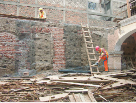
Figura 7: Colocación parcial de mallas de polímero en uno de los muros de ladrillo del primer piso. Archivo del arquitecto Aldo Lértora, 2010.
