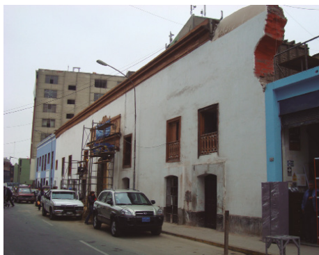
Figura 16. Recubierta de la fachada principal durante la intervención. Archivo del arquitecto Aldo Lértora, 2011.
