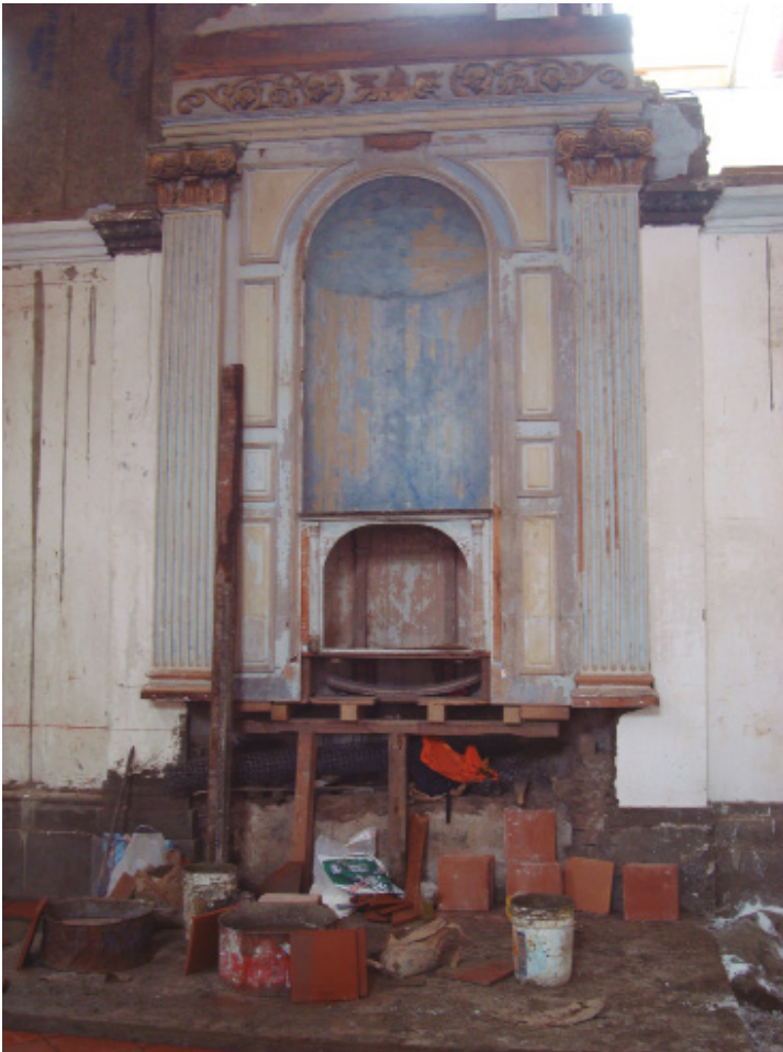
Figura 20. Estado del retablo de la capilla durante los trabajos de restauración. Archivo del arquitecto José María Gálvez, 2011.
