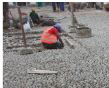
Figura 14. Reposición del canto rodado de uno de los patios tras su limpieza y tratamiento. Archivo del arquitecto Aldo Lértora, 2011.
