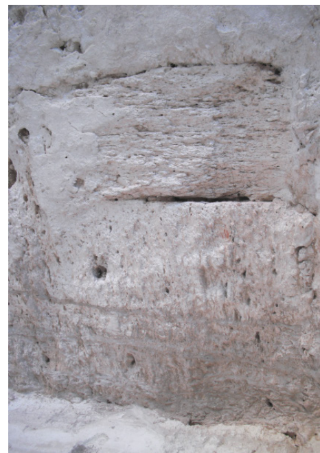
Figura 10. Estratificación de la piedra caliza que ha provocado el desprendimiento del estuco. Archivo fotográfico de las autoras, 2018.
