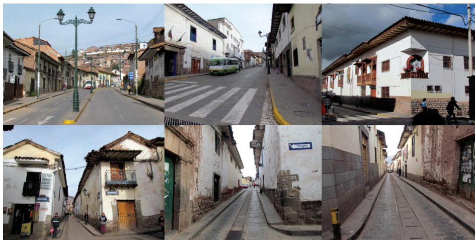
Figura 18. Mejoramiento de la Transitabilidad Vehicular y Peatonal, calles Arcopata y Meloc, Nueva Baja y Vitoque, Avenida Alta y Avenida Baja (postes de alumbrado con diseño anacrónico). Archivo personal del autor.
