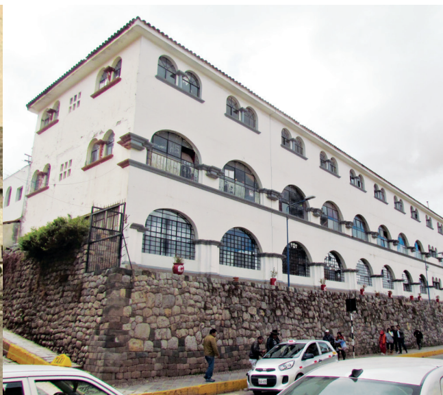
Figura 9. Actual Colegio de Ciencias, edificado sobre andén inca, en la calle Santa Clara. Archivo personal de los autores..
