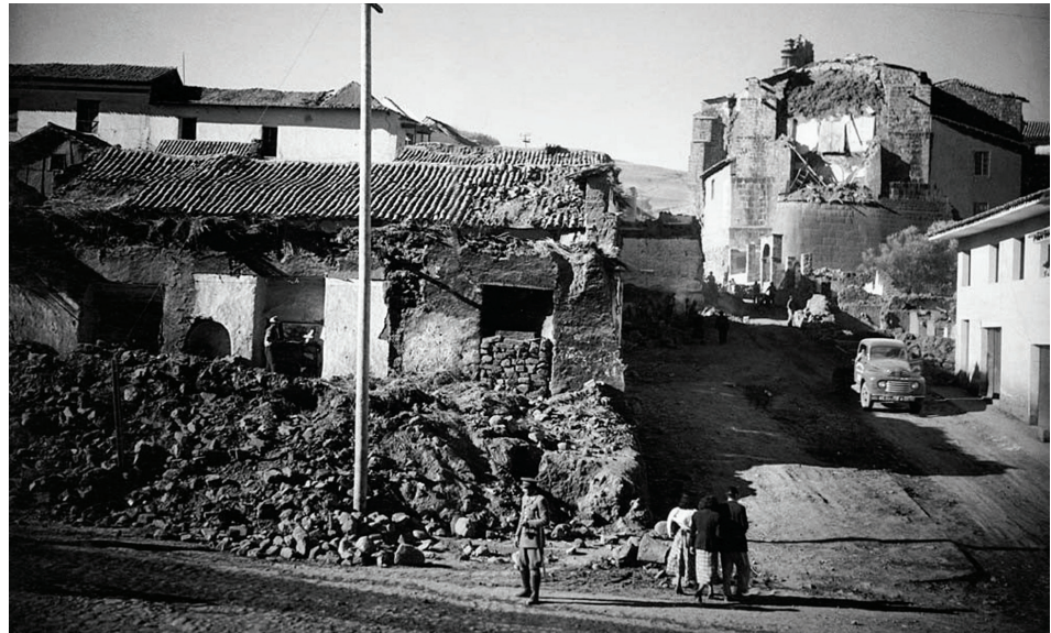
Figura 7. Trabajos de remoción de escombros tras el terremoto de 1950. Archivo de M. Chambi.
