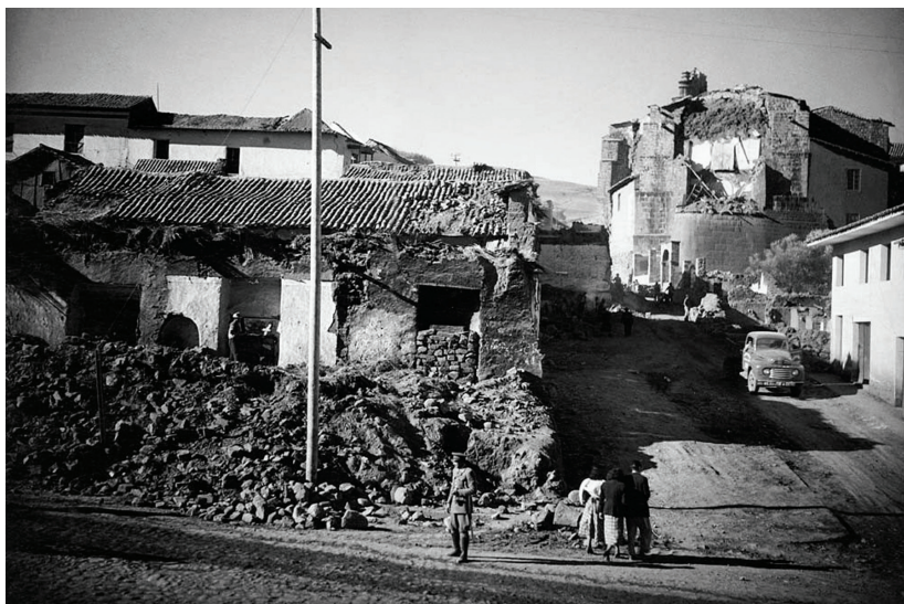
Figura 5. Efectos del terremoto de 1950. Esquina de la av. Sol y la calle Arrayán, al fondo el templo del Qoricancha (fotografía de Martín Chambi). Recuperado de http://limavirreynal.blogspot.com/2008/06/martin-chambi.htm
