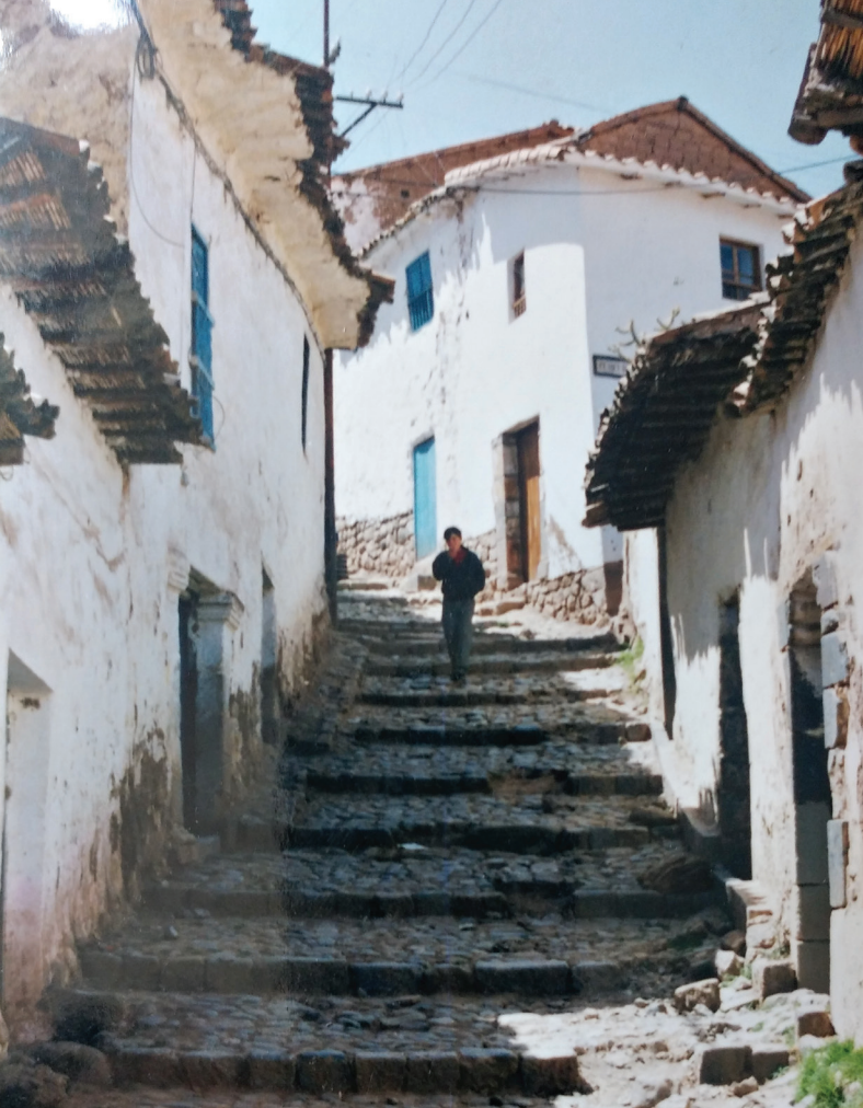
Figura 19. Calle Suytuccato en 1991, antes de la intervención. Archivo personal M. Mostajo.
