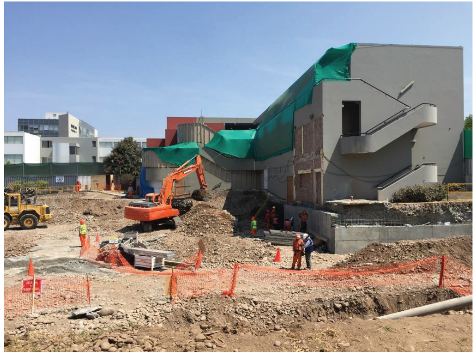
Figura 21. Vista de la obra del nuevo complejo, la cual contó con un plan de monitoreo arqueológico. En Informe Final del Plan de Monitoreo Arqueológico (PMA) durante las Excavaciones y Remoción Masiva de Tierra para la Construcción del “Complejo de Ciencias Sociales - PUCP” (p. 22), por J. Sánchez, 2017. Archivo digital oficina de Obras y Proyectos, Dirección de Infraestructura, Pontificia Universidad Católica del Perú.
