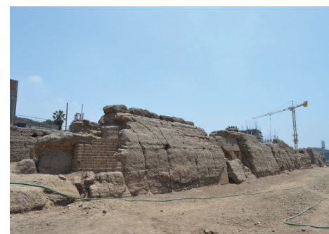
Figura 18. Vista del flanco exterior del muro sur del Camino Inca después de la intervención en el marco del proyecto de investigación, conservación y puesta en valor del Camino Inca. Archivo digital oficina de Obras y Proyectos, Dirección de Infraestructura, Pontificia Universidad Católica del Perú.
