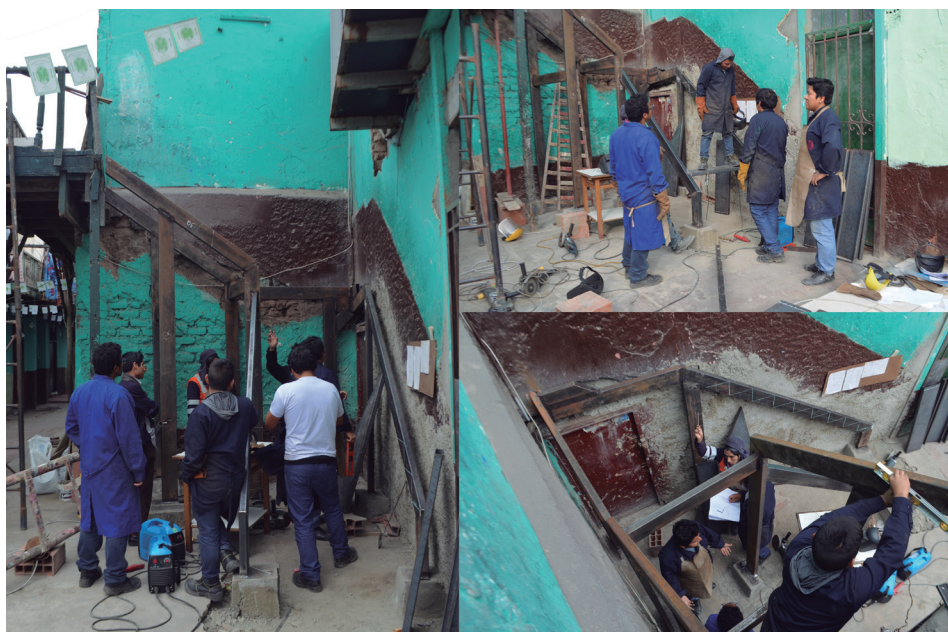
Figura 27. Proceso de armado e instalación in situ
