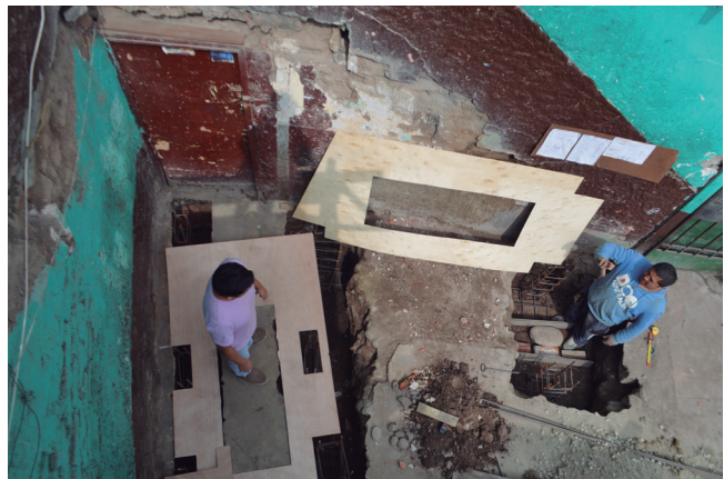
Figura 24. Proceso de armado de encofrados y vaciado de zapatas Fuente: Archivo fotográfico Asociación Habitar, 2016.
