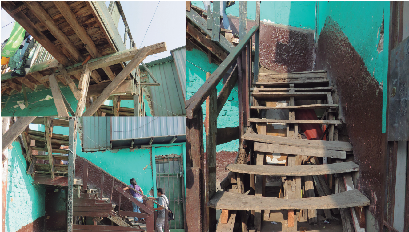
Figura 10. Estado de la escalera antes de la intervención
