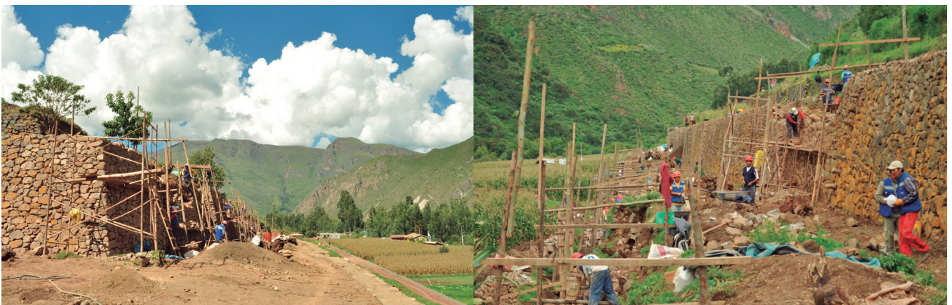
Figuras 15 y 16. Colocación de balizas, guías y andamios para iniciar el trabajo Fuente: Archivo fotográfico Shelby Paz, 2010.
