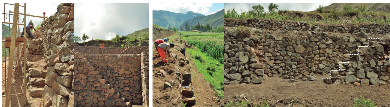
Figura 33. Trabajos de recomposición de escalinatas. Se observa el sistema de trabajo en base a guías empleadas mediante la colocación de balizas; cada pieza fue identificada y codificada.
