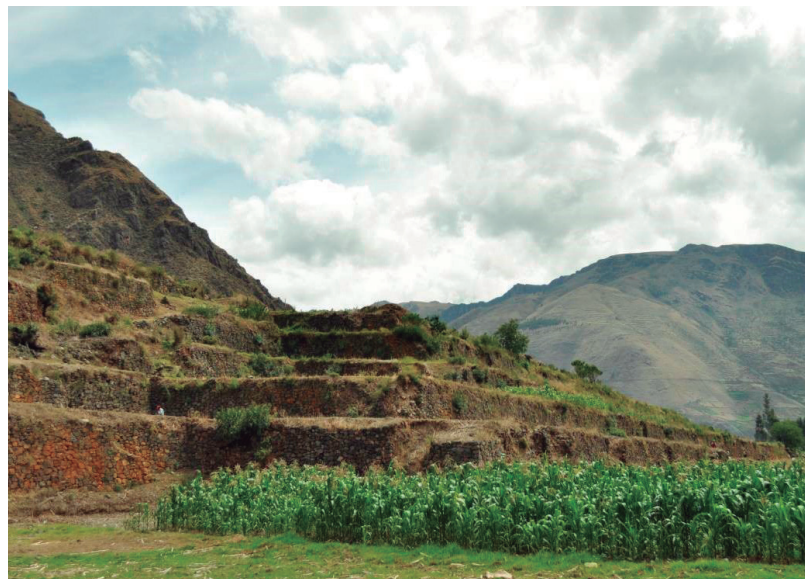
Figura 3. Estado de los andenes antes de la intervención. Vista de las plataformas sin uso, hacia la base cultivos de maíz
