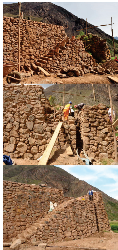
Figura 32. Anden C2. Proceso de excavación arqueológica, trabajos de limpieza y eliminación de maleza, que permitieron evidenciar las estructuras de escalinatas embutidas en este sector
