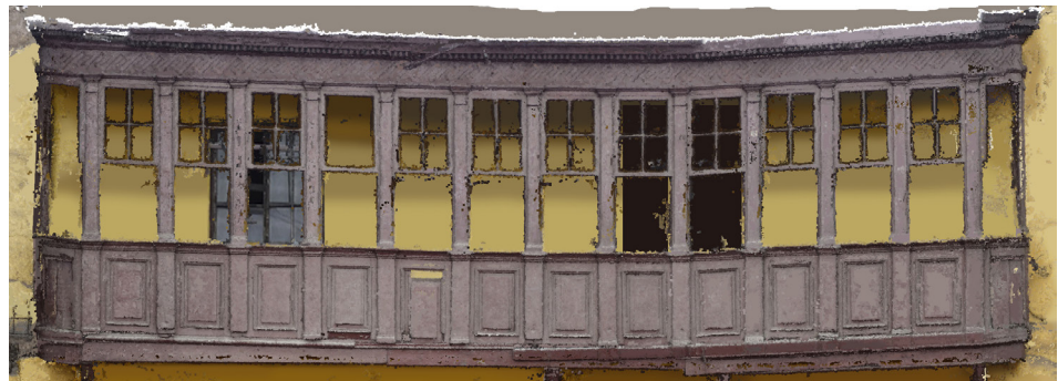
Figura 42. Ortoimagen, elevación del balcón de la Casona Jr. Trujillo Fuente: Elaborado por el autor.
