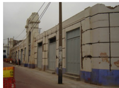
Figura 13. Refuerzos en muros de adobe.
