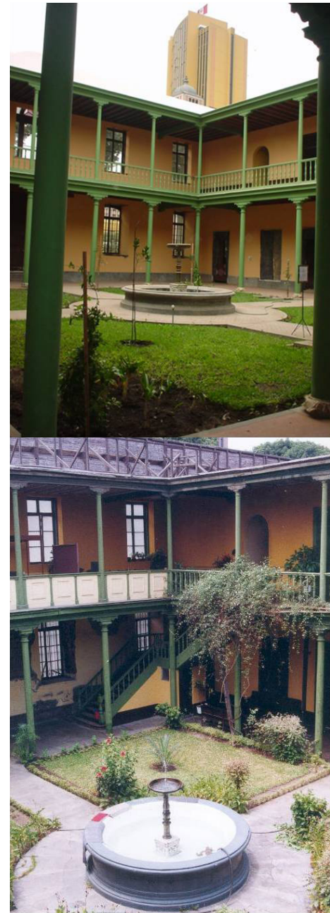
Figura 2. Estado pre y pos intervención del Patio de Ciencias.
