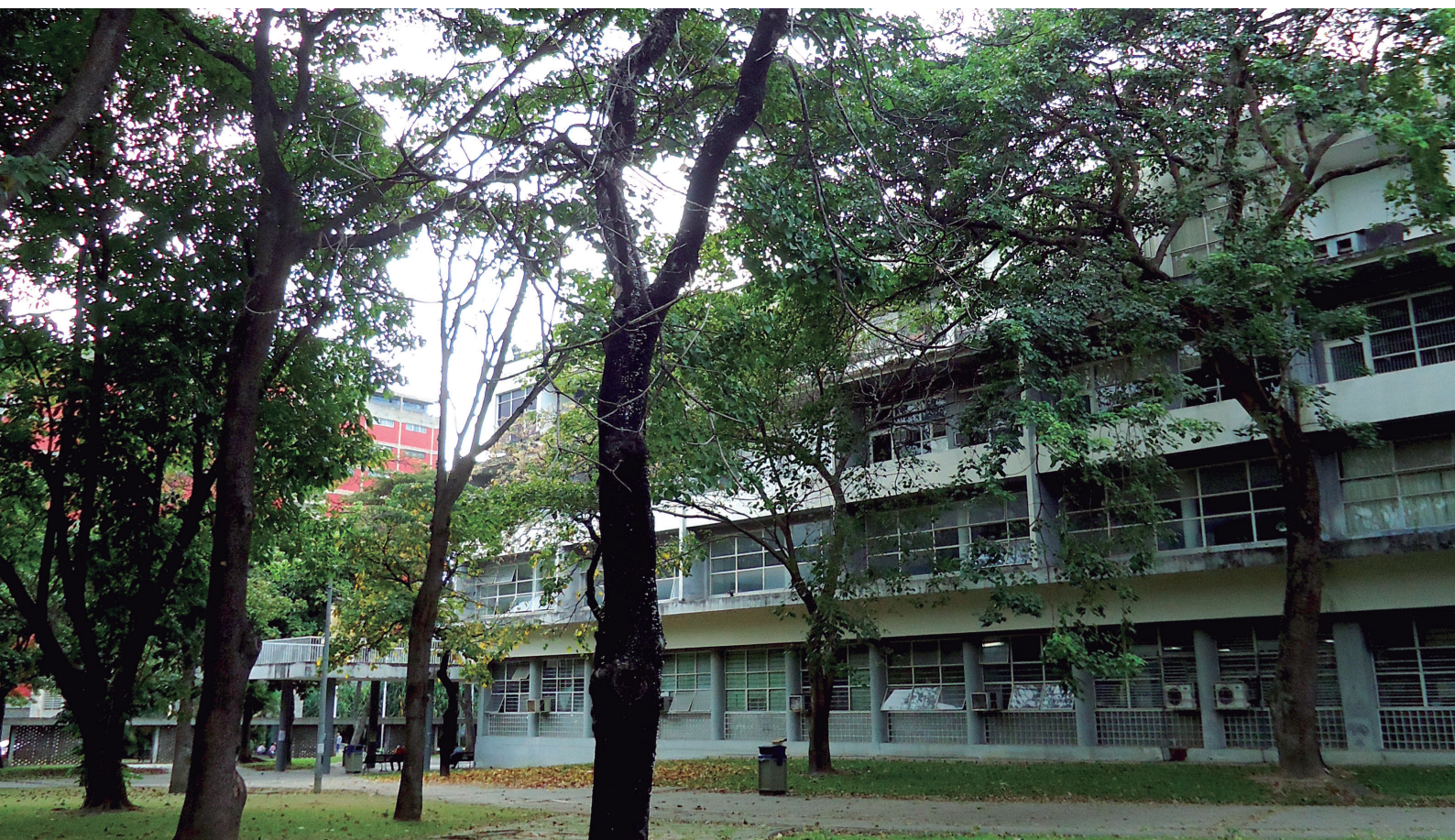
Figura 1 Instituto de Medicina Experimental (Proyecto: 1945-1949. Construcción: 1945-1952).
