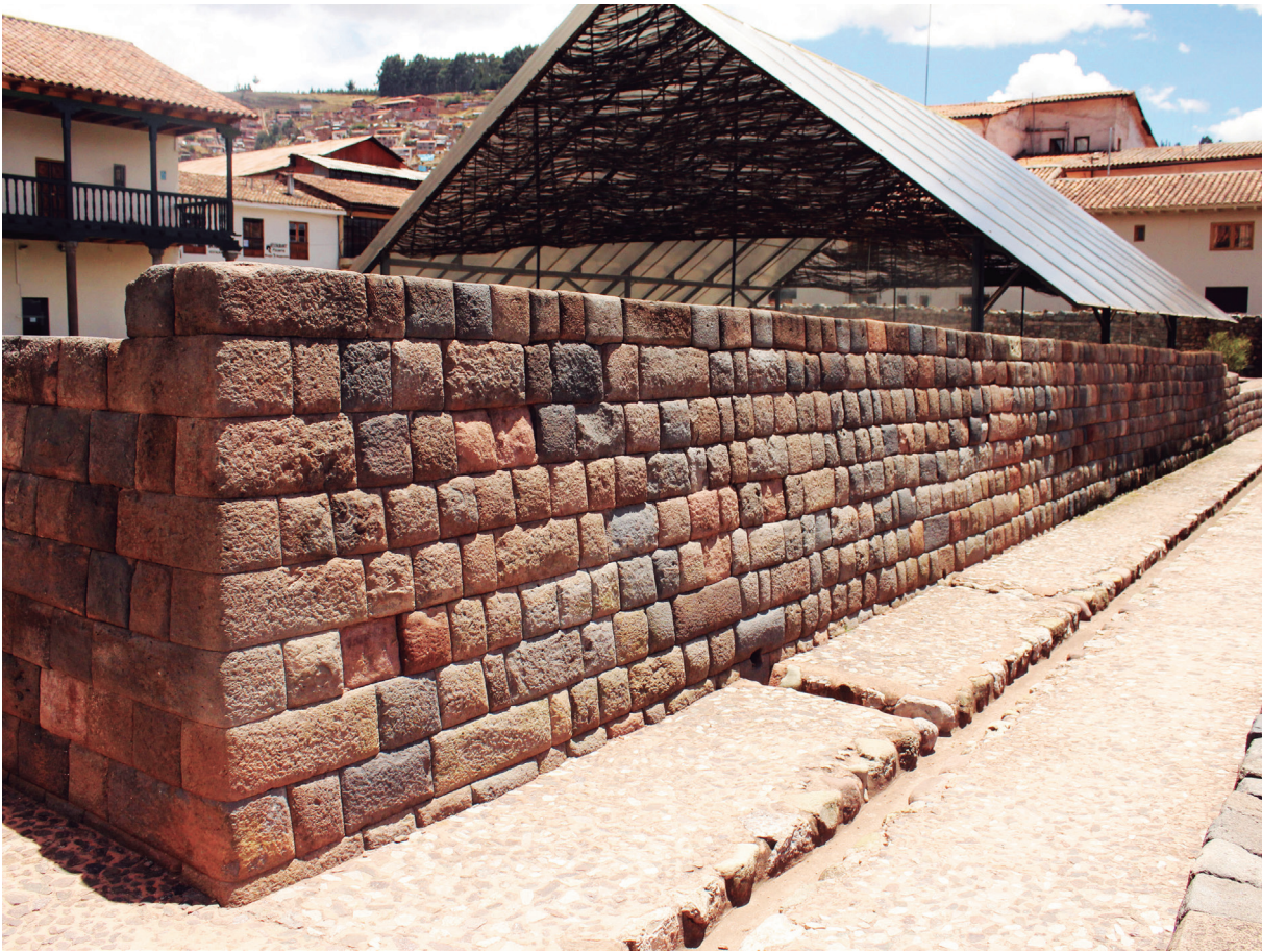
Figura 13 Muro inca restaurado, restituyendo piezas con material histórico local y material tradicional.
