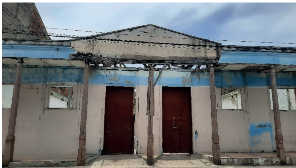
Figura 3. En el siglo XIX prevaleció el uso de la madera rústica en la estructura y el machihembrado en los tabiques, como material fundamental para el levantamiento de estas construcciones y la presencia de antepechos. Nota. Almacén de comercio y gastronomía de la ciudad de Guantánamo, Cuba.
