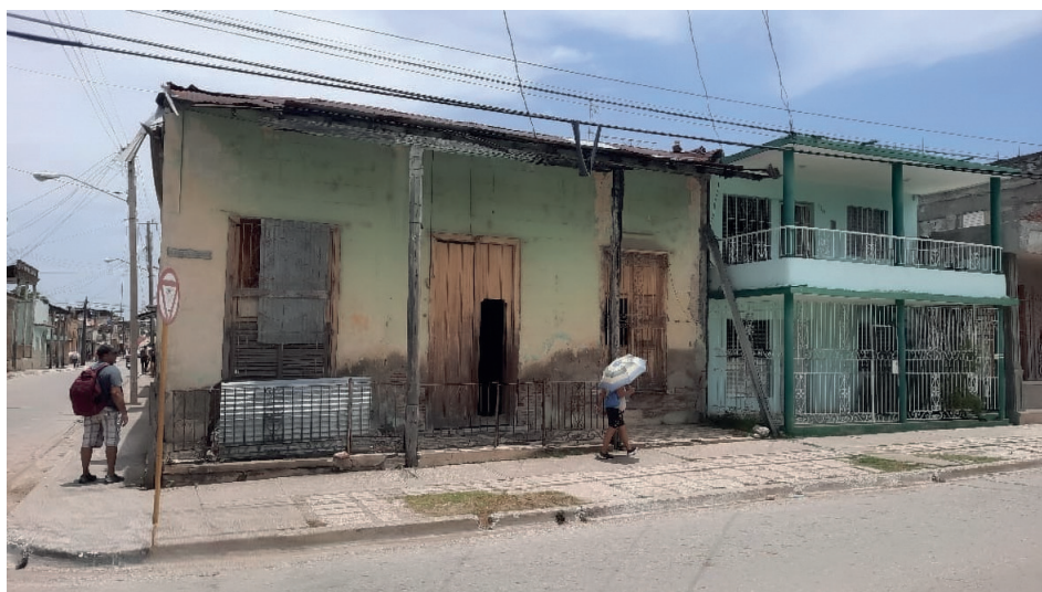
Figura 4. Vivienda patrimonial con problemas en la estructura del techo. Nota. Vivienda patrimonial del sector C de la ciudad de Guantánamo, Cuba, en mal estado de conservación.
