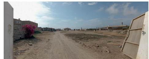
Figura 7. Ex estación ferroviaria de Puerto Eten Nota. Palimpsesto edificado, actualmente en completo estado de abandono. Fotografía tomada por el equipo de investigación, en 2024.
