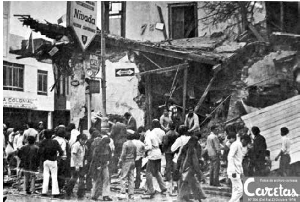
Figura 6. Derrumbe de muro de vivienda a causa del terremoto de 1974 [fotografía publicada originalmente en la revista Caretas ]. En Enfermería en Desastres: 3 de Octubre de 1974 , por EFEMERIX. Recuperado de http://enfermerix.blogspot.com/2011/03/enfermeria-en-desastres3-de-octubre-de.html
