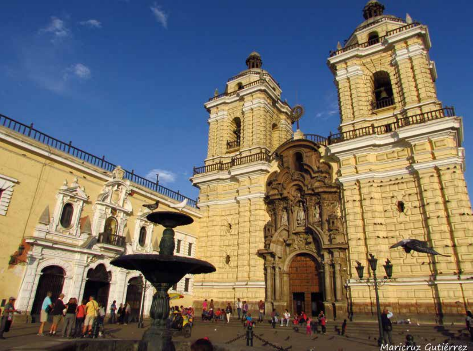
Figura 1. Fachada de la Iglesia de San Francisco de Lima, 2014. Por M. Gutiérrez, recuperado de https://tramuzci.files.wordpress.com/2014/12/sf.jpg
