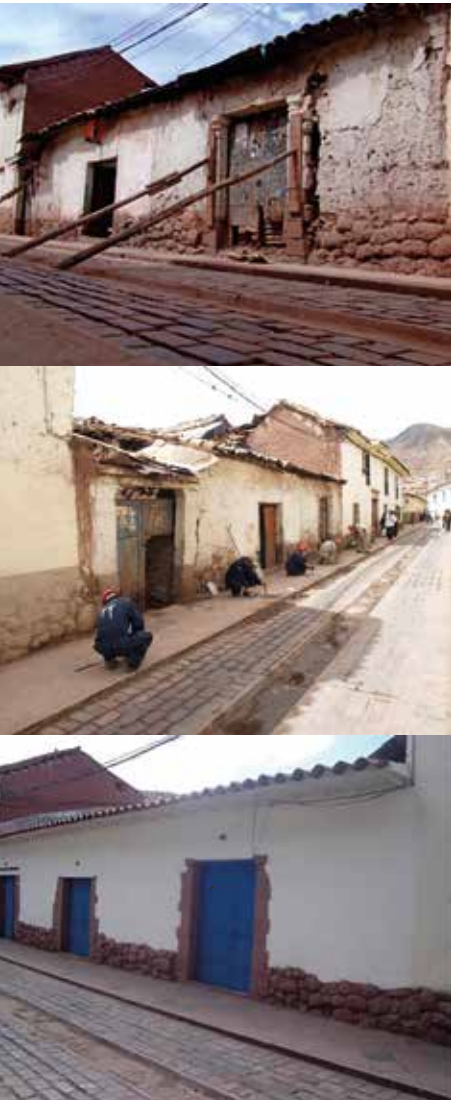
Figura 14. Proceso de intervención para dotación de servicio básicos y rehabilitación de la casa Cabrera, 2009-2014. Sección Intervenciones de la Agencia Española de Cooperación Internacional para el Desarrollo. Centro de Documentación de la Gerencia del Centro Histórico, Municipalidad Provincial del Cusco, 2014.
