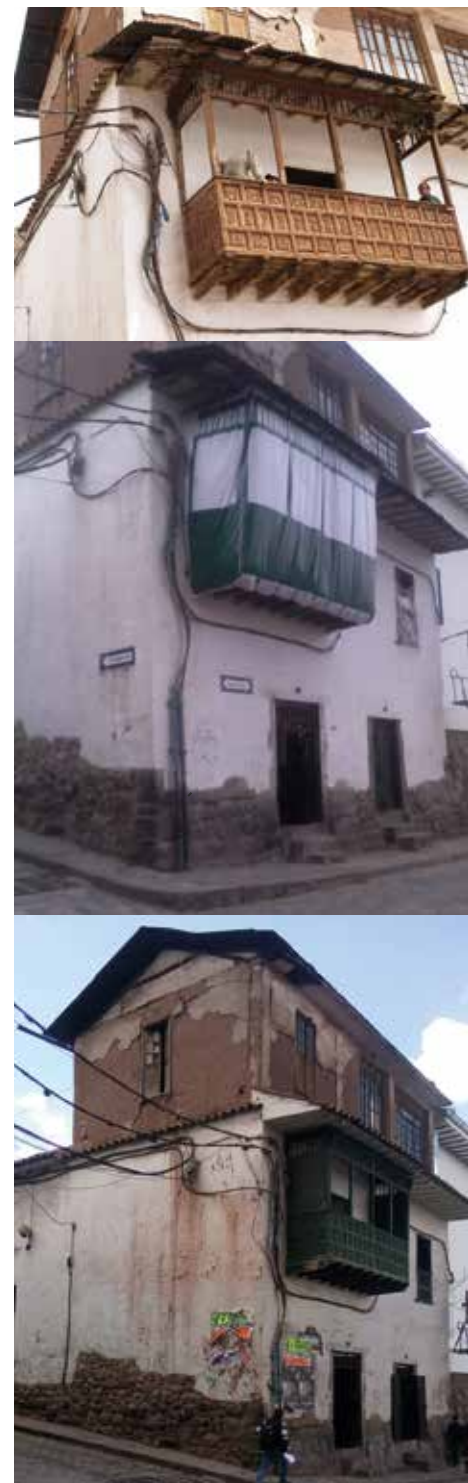
Figura 12. Proceso de recuperación del balcón de la casa Lobatón, 2009-2014. Sección Intervenciones de la Agencia Española de Cooperación Internacional para el Desarrollo. Centro de Documentación de la Gerencia del Centro Histórico, Municipalidad Provincial del Cusco, 2014.
