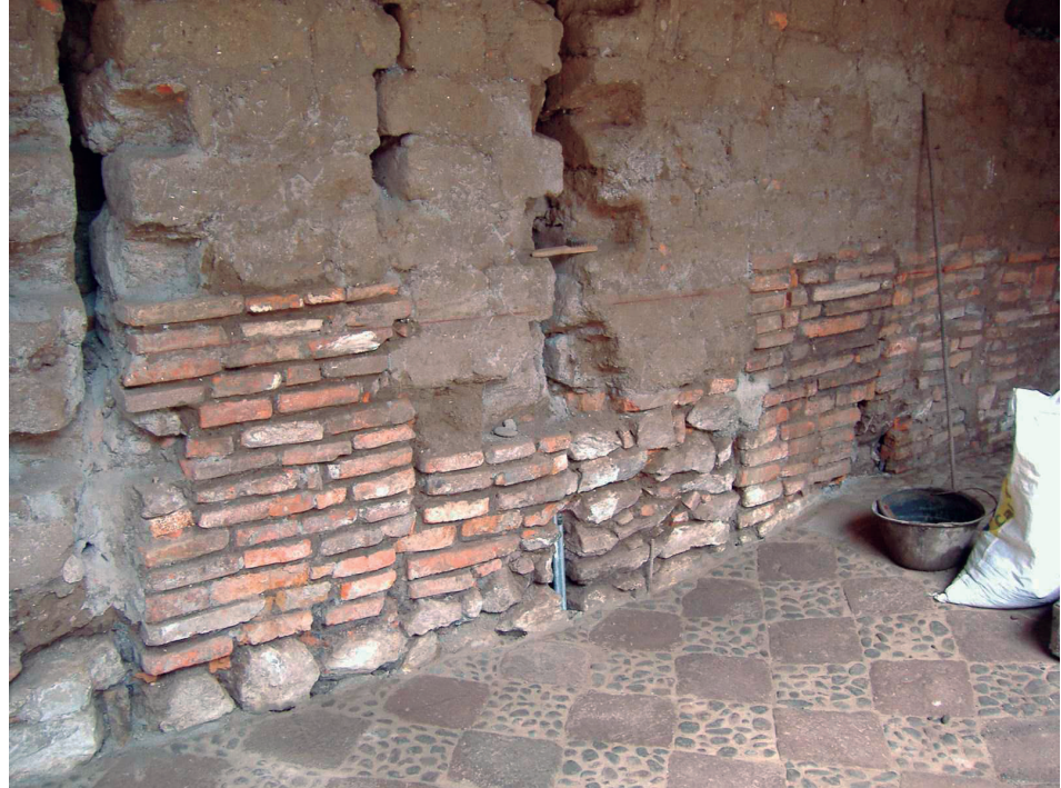
Figura 1. Muro de adobe con base de ladrillo y cimientado de piedra limpio de desprendimientos y material extraño. Restauración de la Casa del Alabado (s. XVII), Quito, 2006. Archivo fotográfico de Héctor Abarca.
