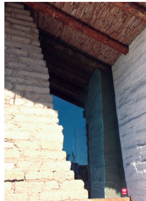
Figura 12. Cerramiento con cristal templado en un muro de adobe que se decidió dejar incompleto en la restauración del Real Presidio de Santa Bárbara del 2006. Fotografía por Héctor Abarca, 2015.
