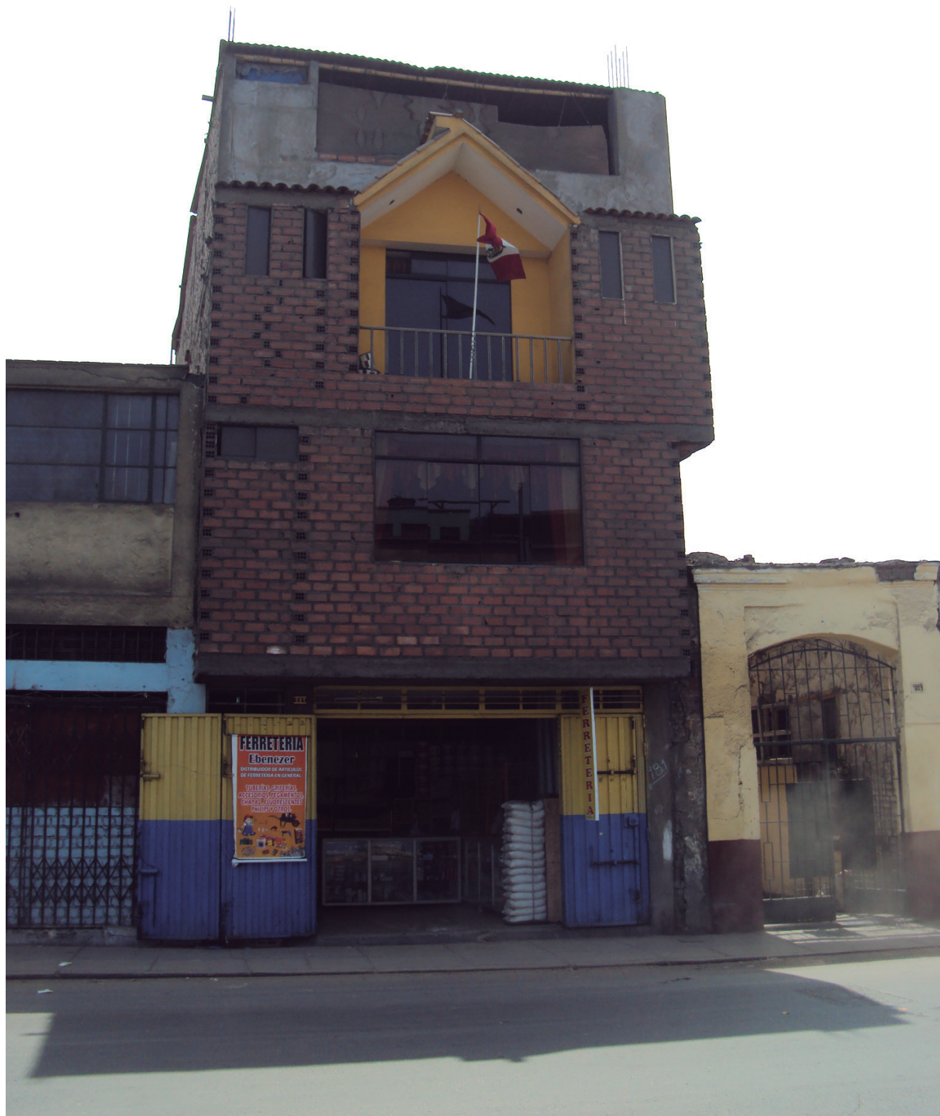
Figura 3. Intervenciones arquitectónicas de mala calidad en los Barrios Altos. Archivo fotográfico personal A. Urdanigue, 2011.
