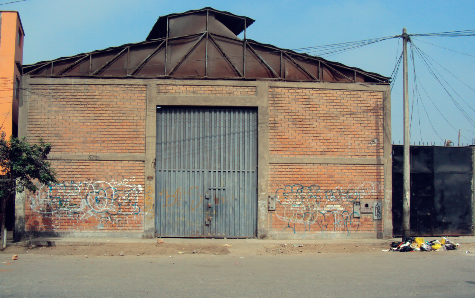
Figura 1. Usos no compatibles que aumentan el deterioro del entorno urbano de Barrios Altos. Archivo fotográfico personal A. Urdanigue, 2011.
