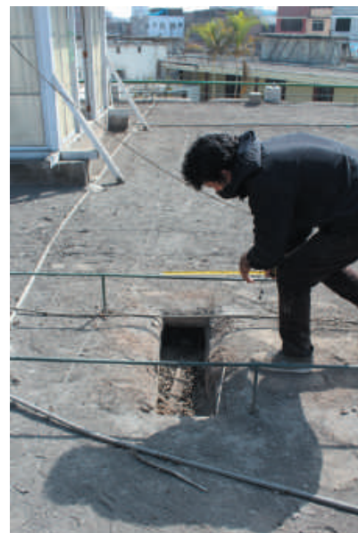
Figura 17. Toma de aire fresco en el techo sobre el muro medianero
