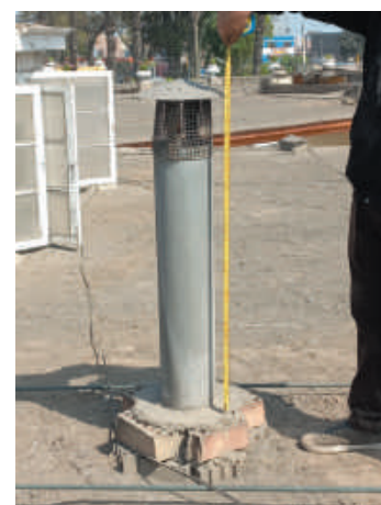
Figura 14. Detalle de una chimenea metálica, no en funcionamiento, instalada en el eje de los muros medianeros según el proyecto de Mateo Graziani para la ventilación de las salas de enfermería
