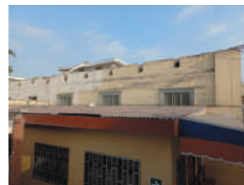
Figura 15. Muro lateral de una de las salas de enfermería donde son visibles las tomas de aire fresco
