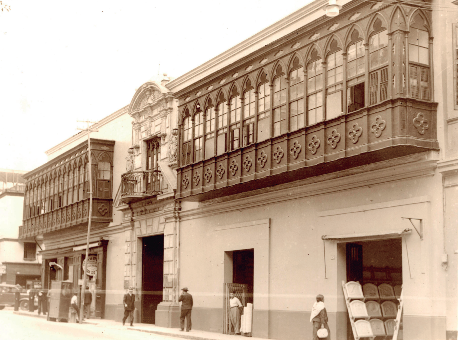
Figura 1. Vista general de la fachada en la década de 1930. Adaptado de Vista general de la fachada, Anónimo, década de 1930. Archivo fotográfico de la Municipalidad Metropolitana de Lima.
