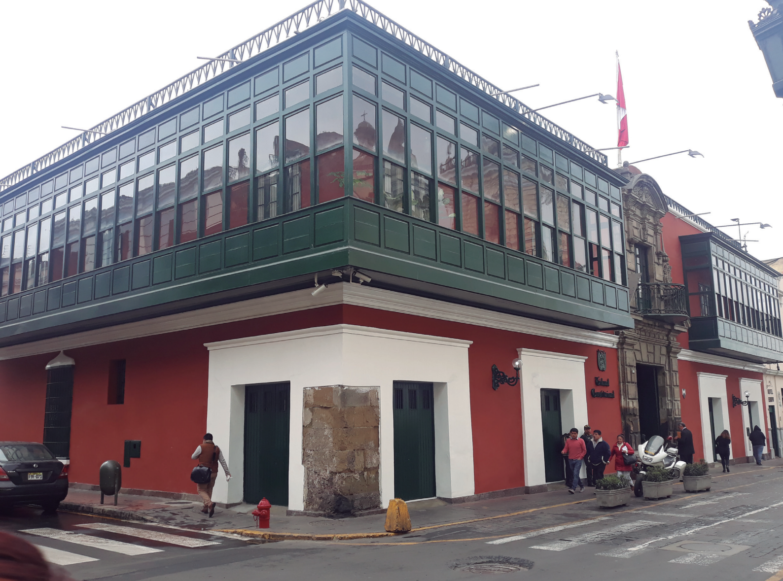
Figura 13. Vista lateral de la fachada, 2019
