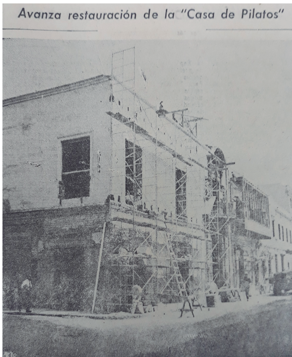
Figura 7. Vista de los trabajos de restauración de 1963. Adaptado de "Vista de los trabajos de restauración" (p. 3), Anónimo. El Comercio , 25 de abril 1963.
