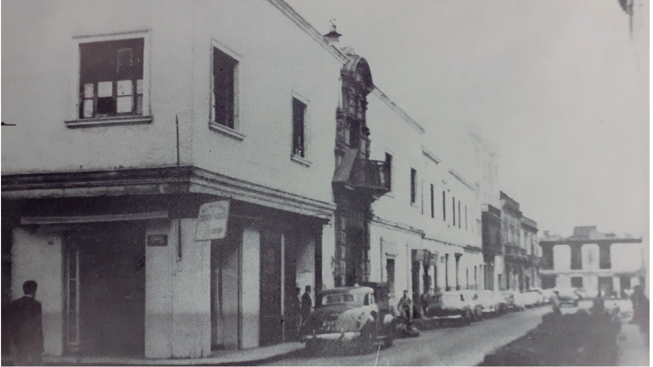
Figura 4. Vista de la casa sin balcones anterior al proyecto de restauración de 1963. Adaptado de "Vista de la casa sin balcones antes del proyecto de restauración" (p. 16), por Héctor Velarde, 1963, Revista Peruana de Cultura, I.
