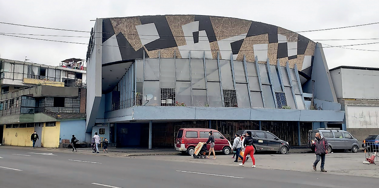
Figura 4. Vista frontal del cine Tauro.
