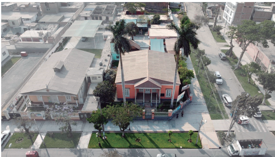
Figura 2. Vista aérea de la Junta de Beneficencia de Chosica
