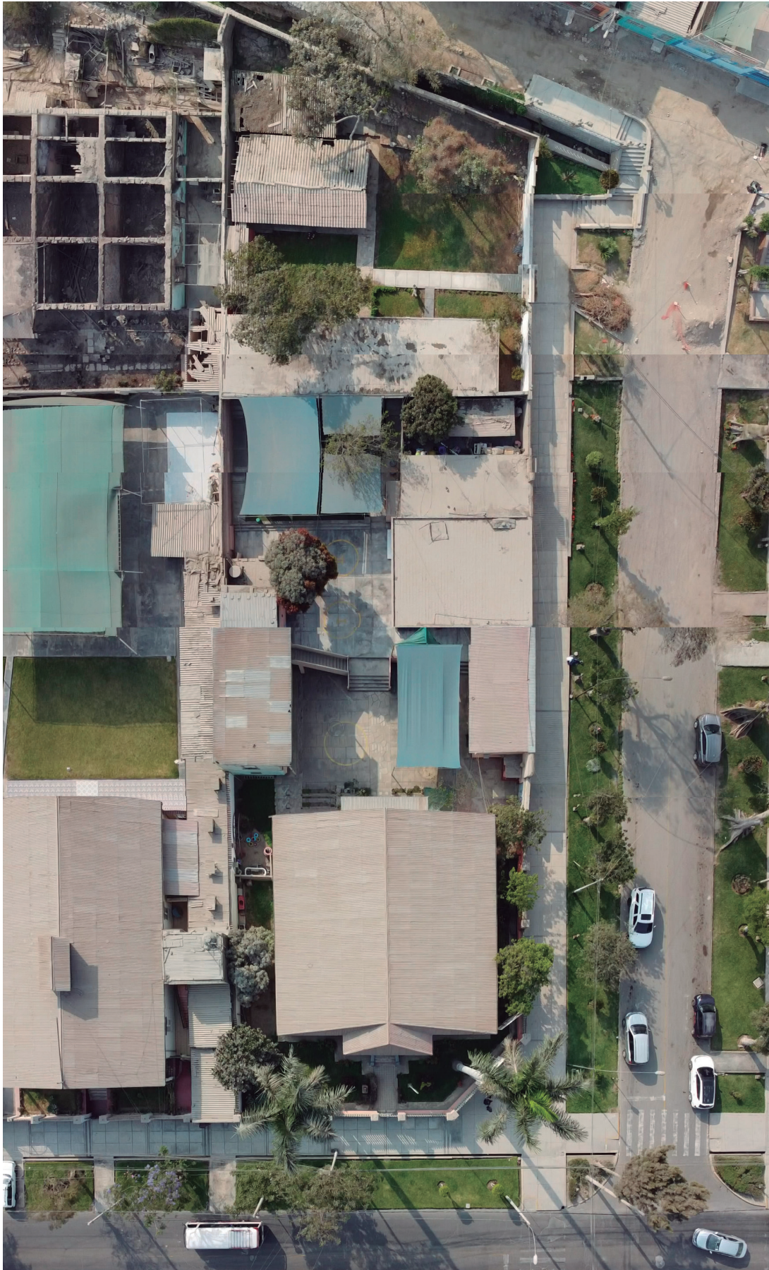
Figura 7. Fotografía aérea del edificio de estudio (2021)
