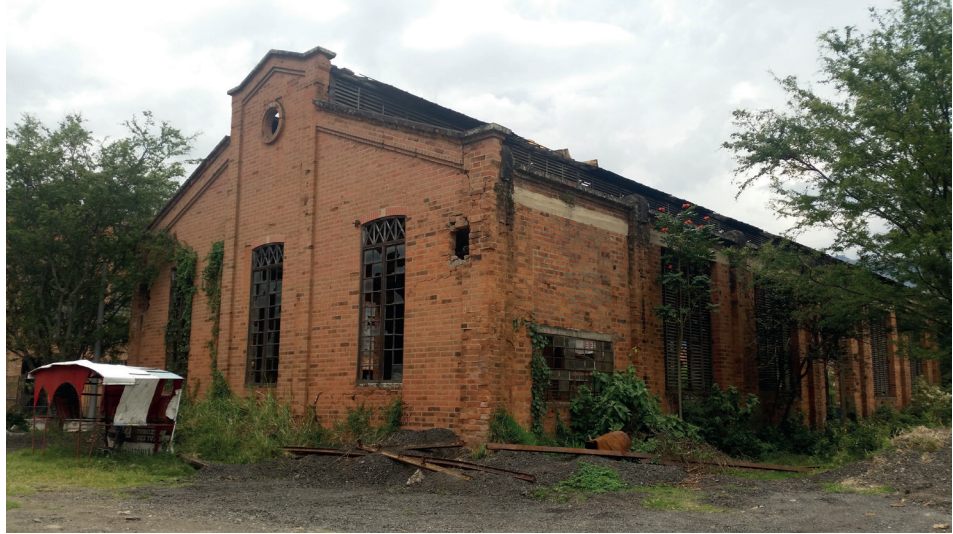
Figura 20. Exterior del edificio F, hojalatería, tracción y electricidad diésel. Semillero de investigación Patrimonio Industrial y Ferroviario, Conjunto ferroviario Talleres de Bello, 2018.
