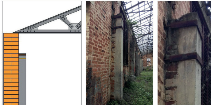
Figura 24. Columnas anexas en concreto reforzado adosadas a la estructura general del edificio "F". De los autores a partir de sistemas CAD, 2018.
