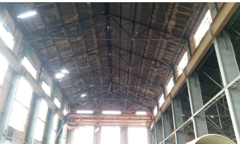
Figura 5. Interior del edificio Diésel. Semillero de investigación Patrimonio Industrial y Ferroviario, Conjunto ferroviario Talleres de Bello, 2018.
